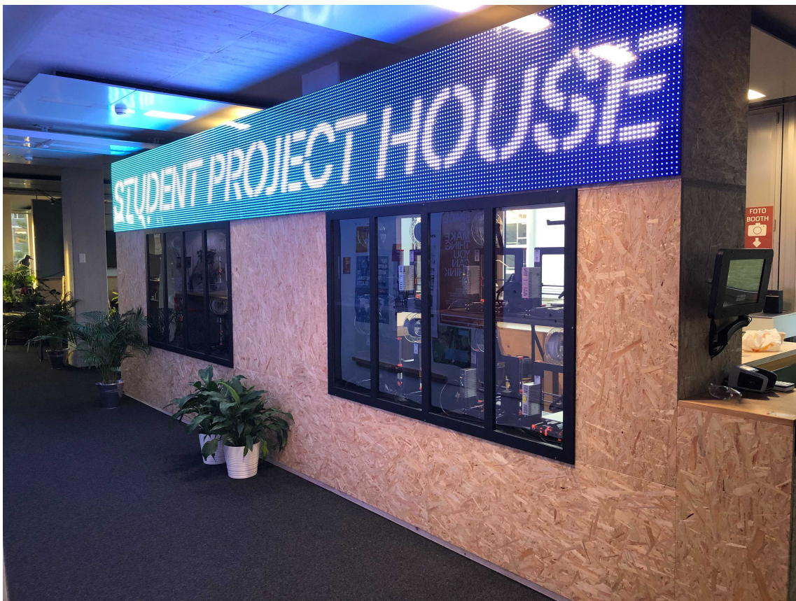
Selbst-designte Wand aus OSB Holz mit LED-Platten (oben), welche zu einer beispielbaren LED-Wand mit sich bewegenden Schriftzügen in allen Farben programmierbar ist (unten).
